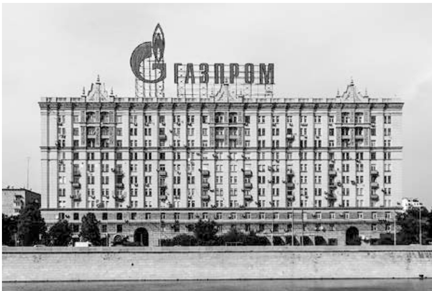
Gazprom Gebäude in Moskau. (Foto: 52655f / Wikimedia Commons / CC BY 3.0)
