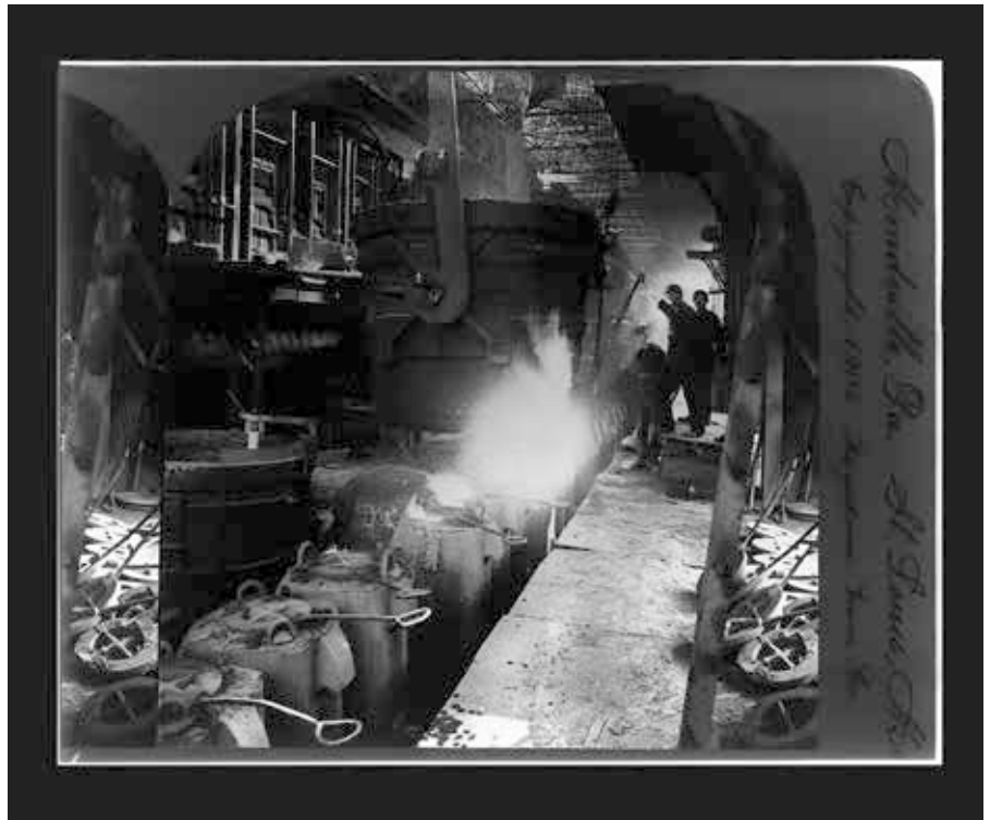
Stahlwerk in Pittsburgh, Pennsylvania, um 1905. (Foto: Unbekannt, Wikimedia Commons, Gemeinfrei)
