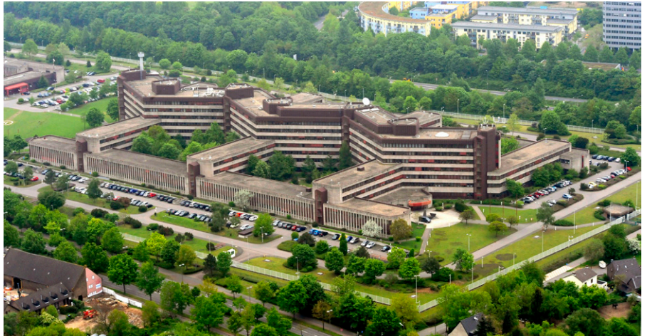
Foto des BfV-Dienstgebäudes in Köln, (Pressefoto BfV)
