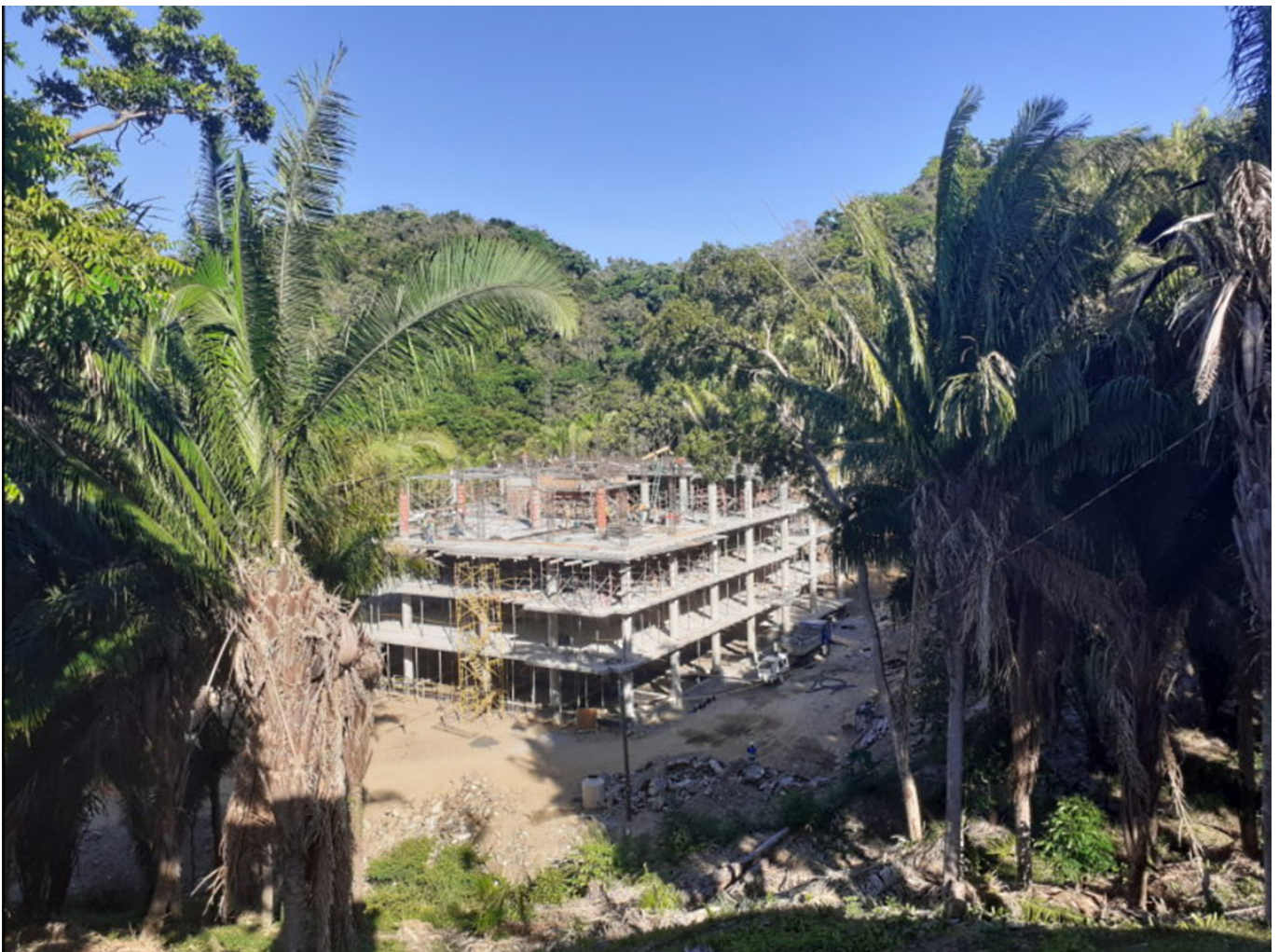
Blick auf die Großbaustelle der ZEDE Próspera , 2022. (Foto: HondurasDelegation, CC BY 4.0 Deed)
