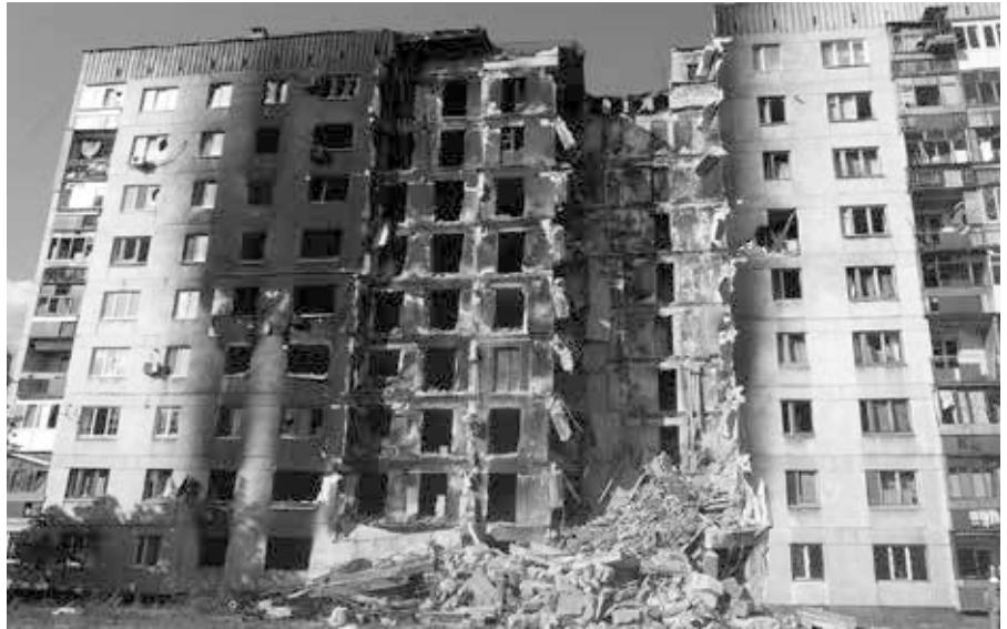
Während des Krieges im Donbass zerstörtes Wohngebäude. Lyssytschansk, Gebiet Lugansk, 4.8.2014. (Foto: Lyonking, Wikimedia Commons, CC-BY-SA-4.0)
