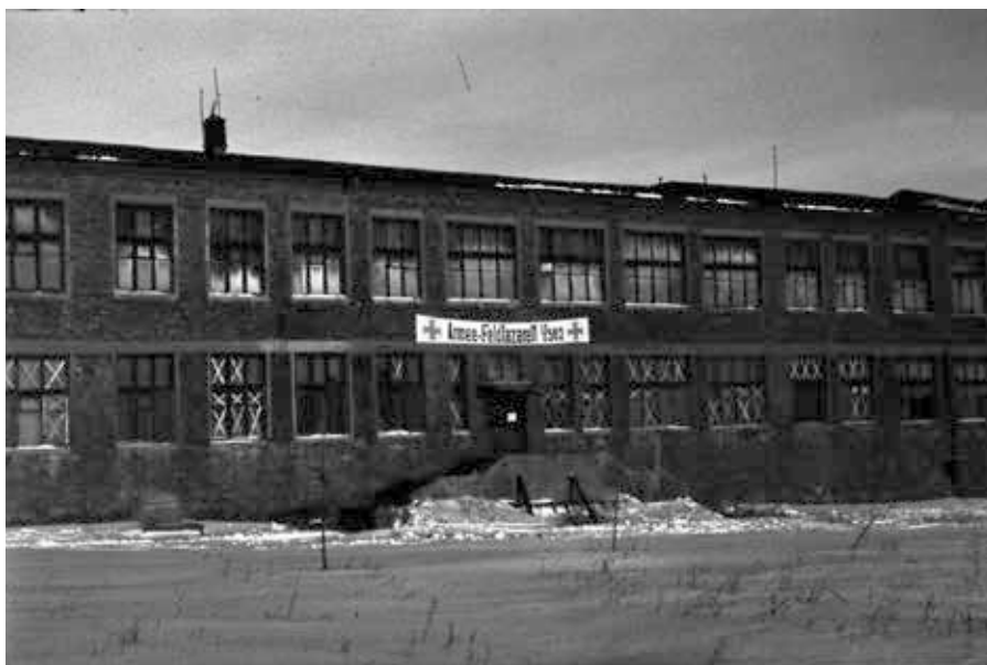
Chirurgie des Städtischen Krankenhauses Konstantinowka (Januar 1942), von der Wehrmacht als Armee-Feldlazarett beschlagnahmt (Foto: Viktor Becker)
