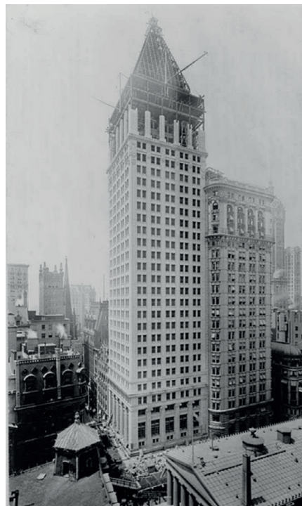
Gebäude der Bankers Trust Co. im Bau, New York, 20.6.1911. (Foto: Irving Underhill, picryl.com, Gemeinfrei)
