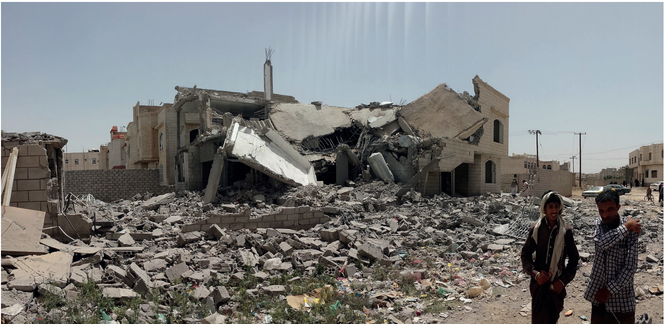
Zerstörung im Süden Sanaas durch einen Luftangriff vom 12. Juni 2015 während der Operation Restoring Hope (Foto: 13. Juni 2015) (Foto: Ibrahim Qasim, Wikimedia Commons, CC BY-SA 4.0)
