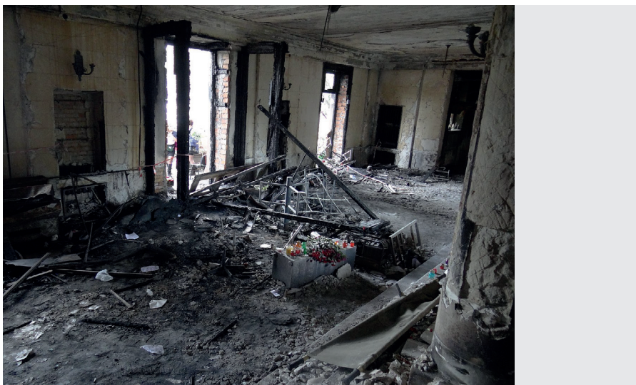
Im Inneren des Gewerkschaftshauses in Odessa nach dem Feuer - Foto: Lsimon , CC BY-SA 4.0
