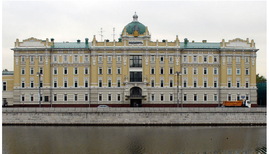
Zentrale des russischen Mineralölunternehmens Rosneft in Moskau am Ufer der Moskwa (Foto: NVO, Wikipedia.org, CC BY 3.0)
