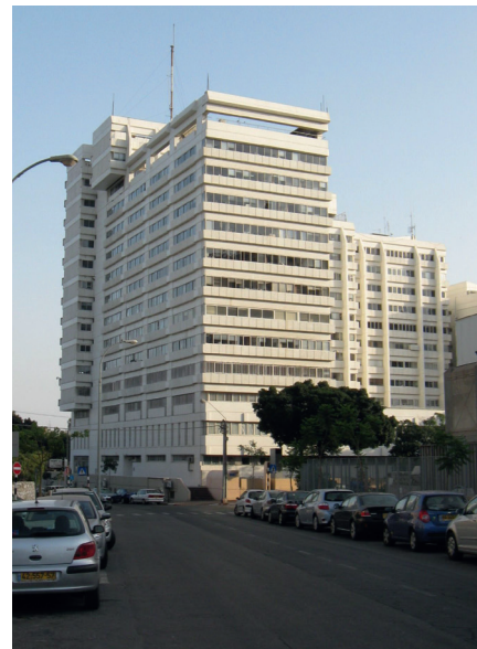
Hadar-Dafna-Gebäude, Zentrale des Mossad in Tel Aviv (Wikimedia Commons)
