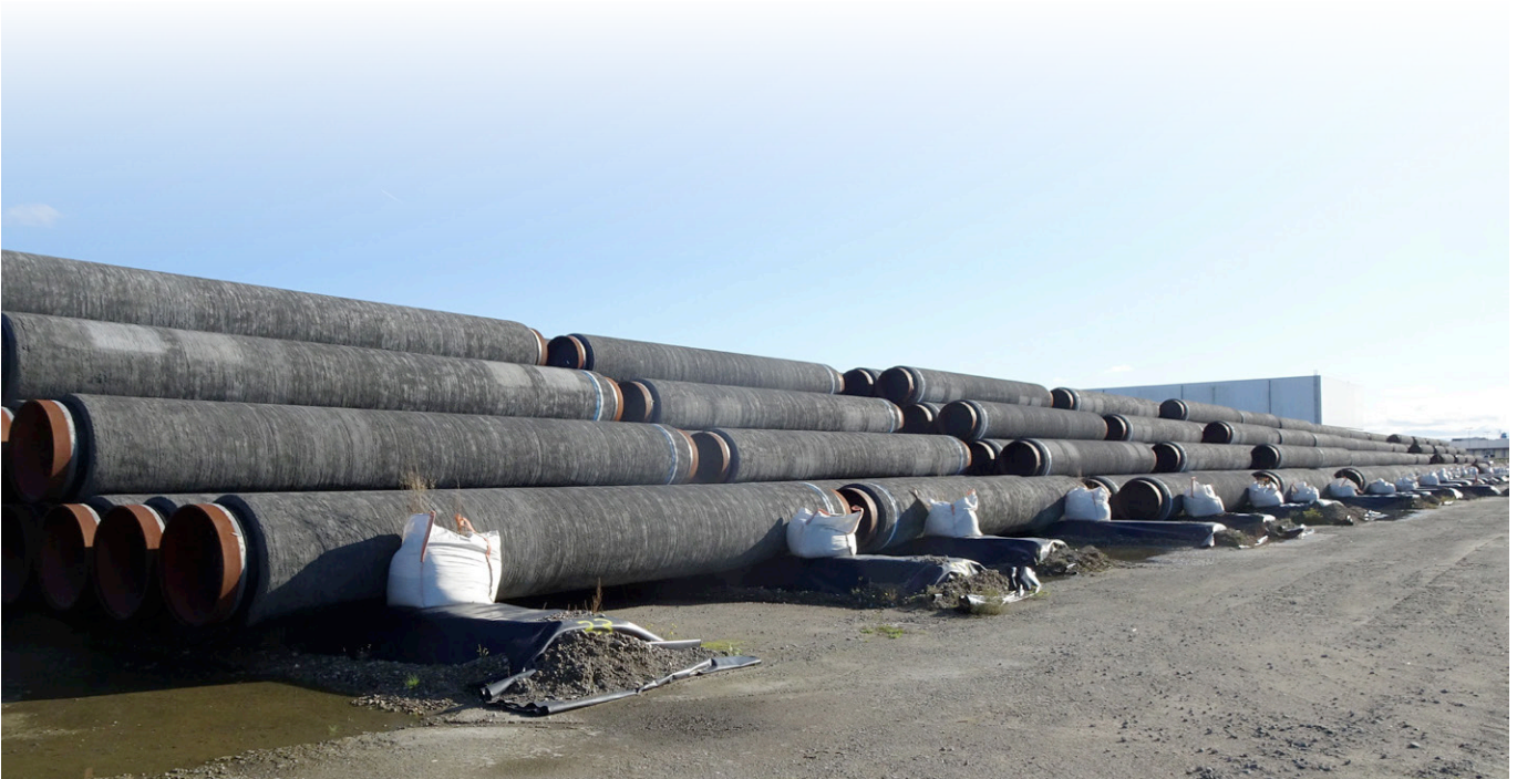
Rohre für Nord Stream 2 in Mukran/Sassnitz auf der Insel Rügen, 30.10.2019. (Foto: Gerd Fahrenhorst, commons.wikimedia.org, CC BY 4.0)
