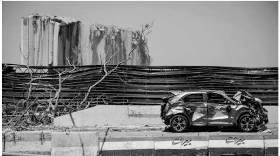
Schäden nach der Explosion am 4. August 2020 in Beirut. (Foto: Mehdi Shojaeian, 9.8.2020, commons.wikimedia.org, CC BY 4.0)
