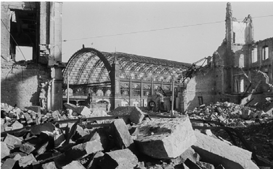
Blick aus den Ruinen an der Jahnstraße zur Ruine der Bahnsteighalle des Bahnhofes Dresden Wettinerstraße. Quelle: https://de.m.wikipedia.org/wiki/Datei:Fotothek_df_ps_0000317_002_Blick_aus_den_Ruinen_an_der_Jahnstra%C3%9F_e_zur_Ruine_der.jpg , Foto: Wikipedia / Richard Peter, Lizenz: CC BY-SA 3.0 DE
