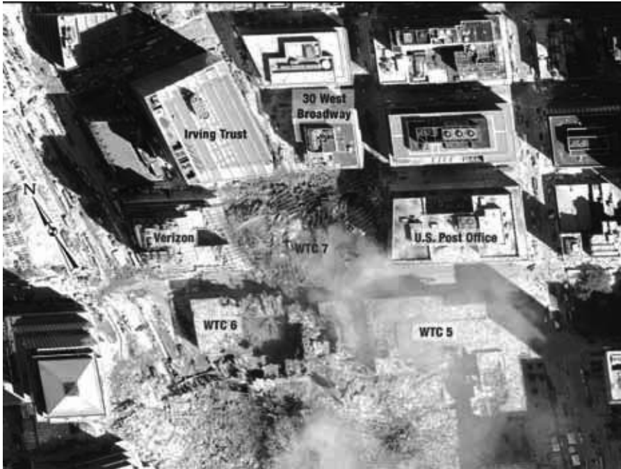
Luftaufnahme vom September 2001 von Trümmern, die durch den Einsturz von WTC 7 entstanden sind (Foto: U.S. Federal Emergency Management Agency/US-Bundesbehörde für Notfallmanagement, http://www.fema.gov/pdf/library/fema403_ch5.pdf , Lizenz: Public Domain)
